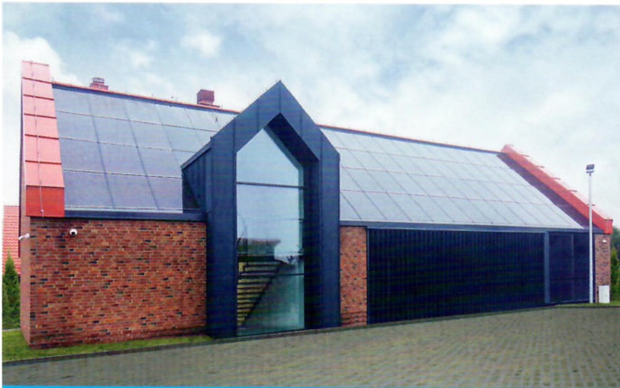
Große Photovoltaikanlagen werden am liebsten auf einem Südseitendach installiert. Bei Sunroof bilden die Paneele sogar die gesamte Dachfläche – eine modern-ästhetische Lösung mit maximaler Abdeckung. ( www.sunroof.se )
